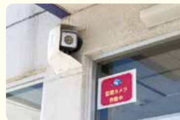
工場入口・工場内に 監視カメラ設置
